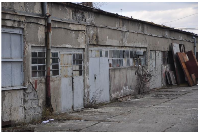
Zdjęcie 6. Zakład produkcji konstrukcji stalowych.
