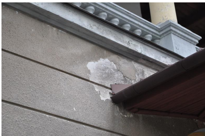
Zdjęcie 3. Klasztor Sióstr Dominikanek. Zewnętrzna elewacja budynku znajduje się w złym stanie technicznym oraz powodujący wyższe koszty użytkowania budynku.
