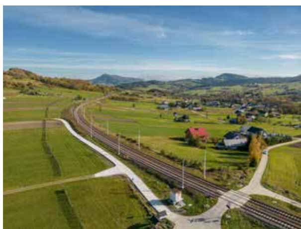
Droga betonowa Ptaszkowa
