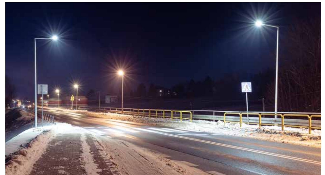
Doświetlenie przejścia dla pieszych DK 28 w miejscowości Cieniawa
