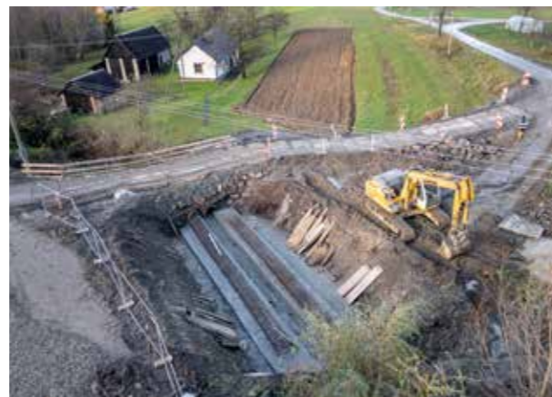
Budowa mostu w Wyskitnej
