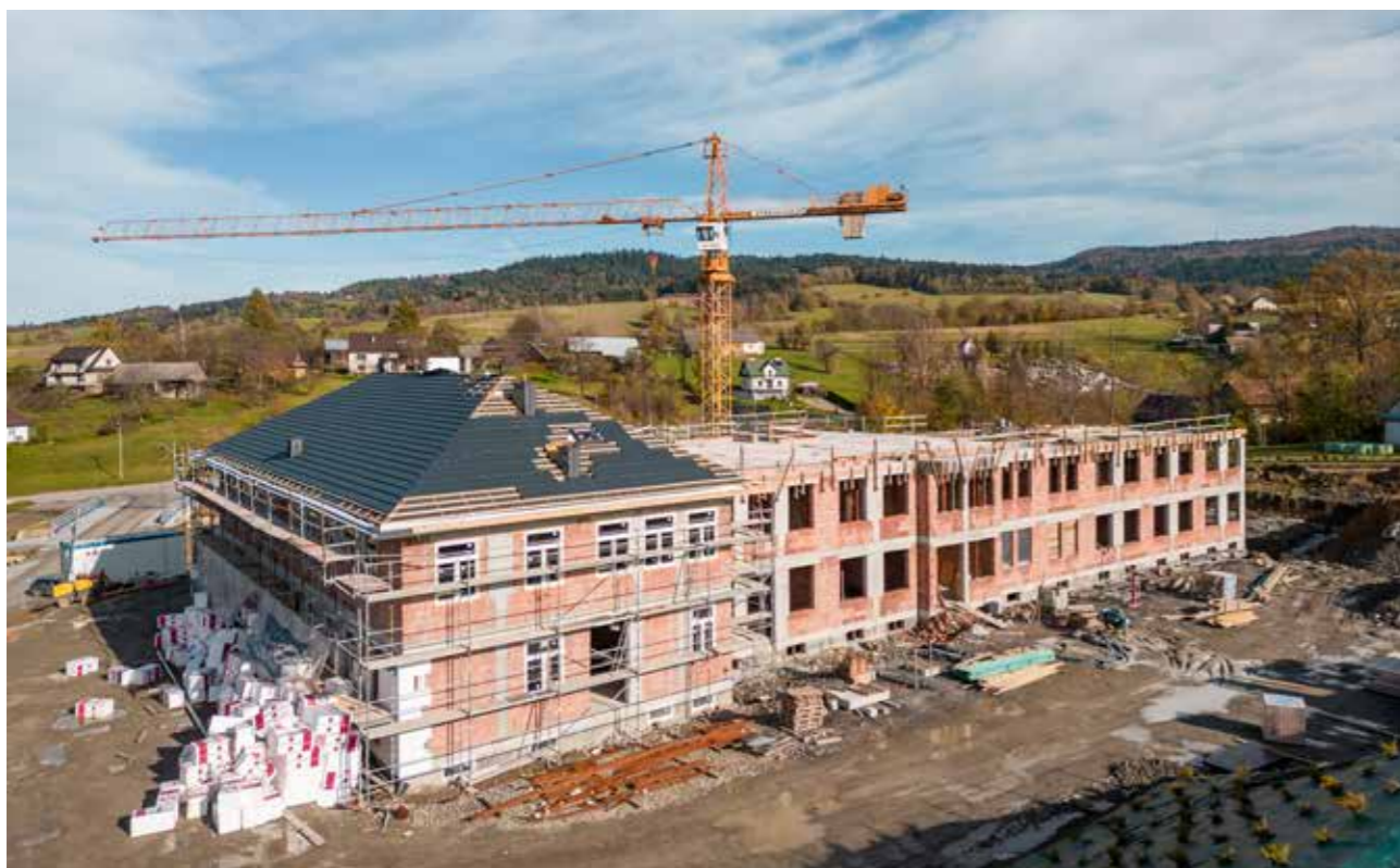
Budowa szkoły w Gródku - II etap
