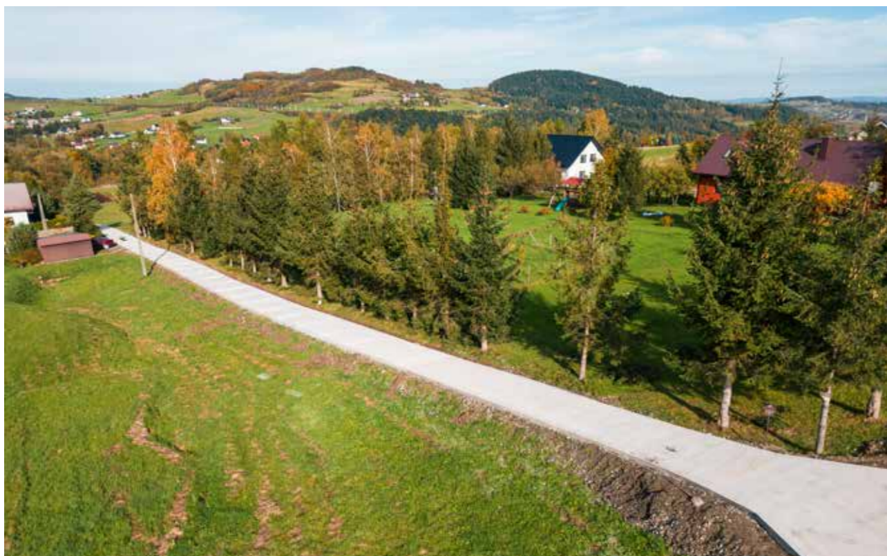
Droga betonowa Ptaszkowa
