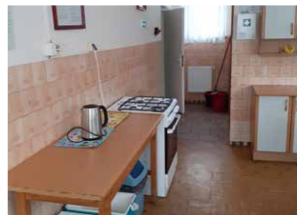
WTZ w Siołkowej przed remontem
