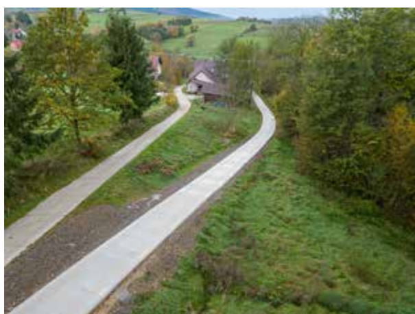
Droga betonowa Krużłowa Wyżna
