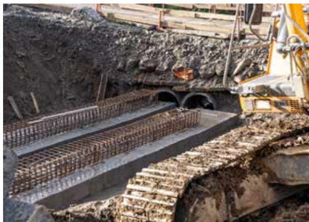
Budowa mostu w Wyskitnej
