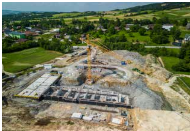
Budowa szkoły w Gródku - I etap
