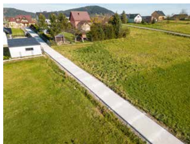
Droga betonowa Cieniawa
