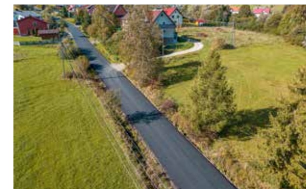
Remont drogi gminnej nr 29500K w m. Florynka
