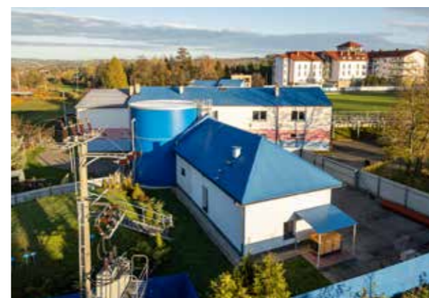
Ujęcie wody w Stróżach
