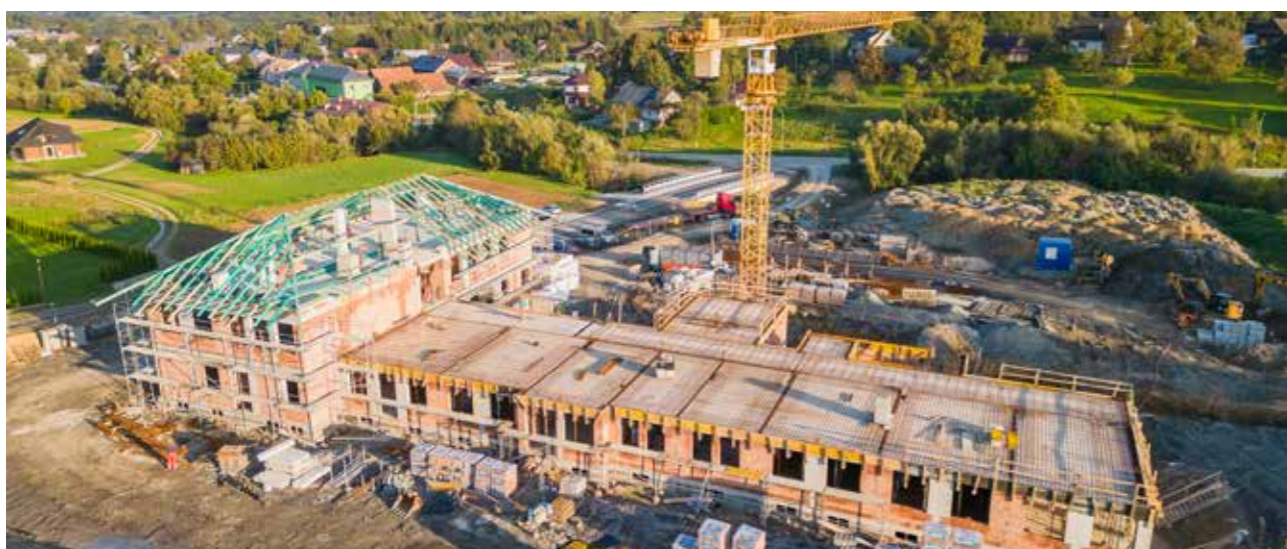
Budowa szkoły w Gródku - II etap
