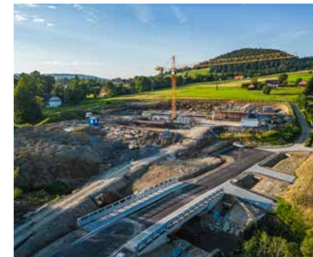
Budowa mostu w Gródku
