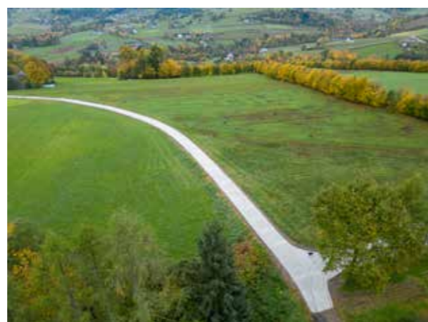
Droga betonowa Krużłowa Wyżna
