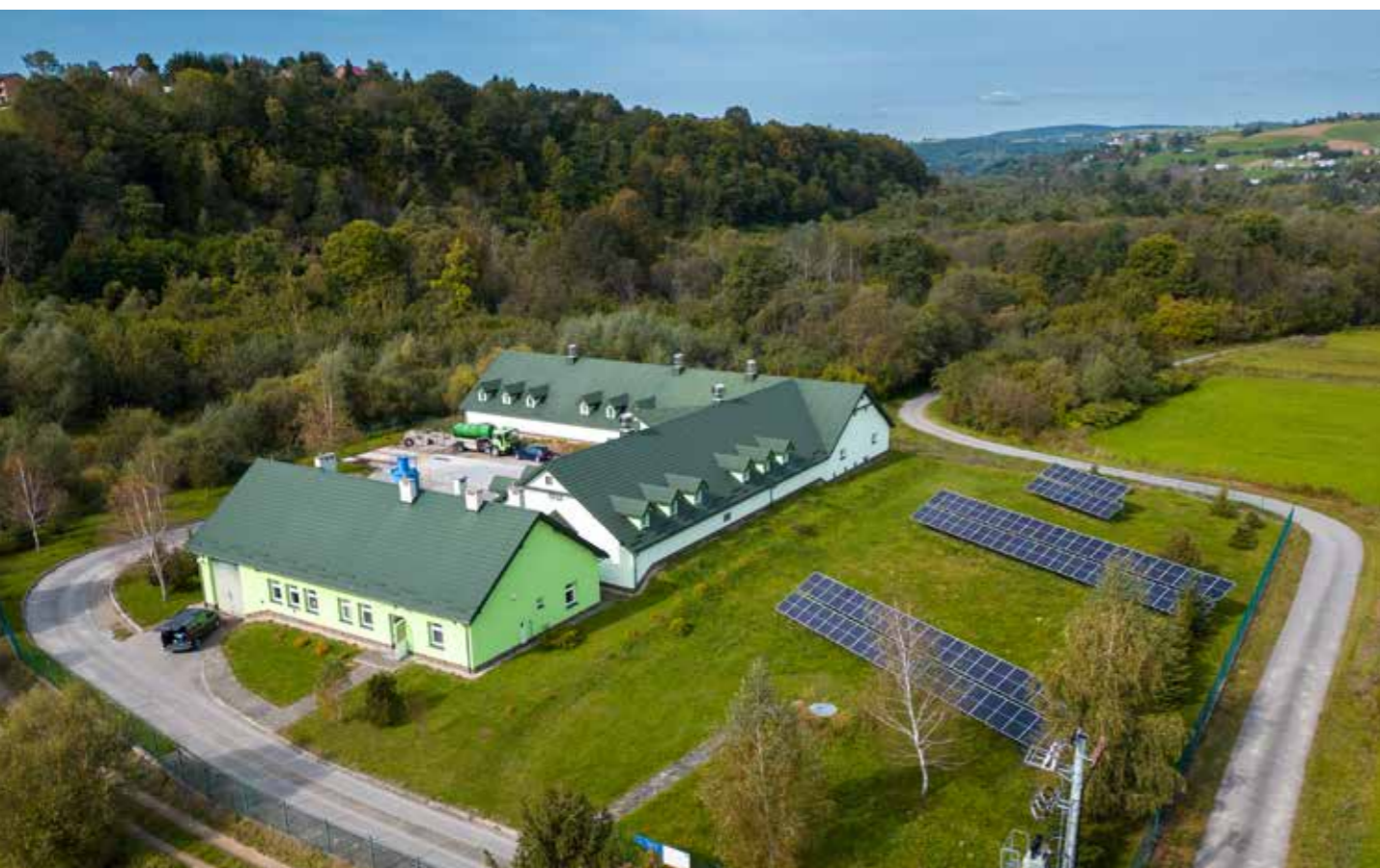
Oczyszczalnia ścieków w Stróżach
