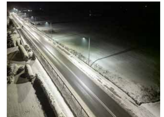
Oświetlenie drogi powiatowej w miejscowości Ptaszkowa
