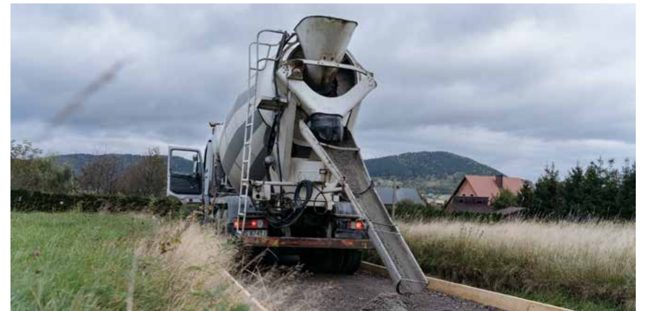
Budowa drogi betonowej
