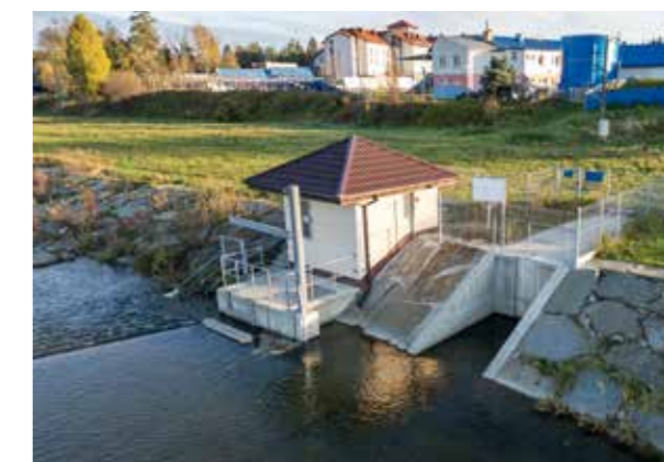
Ujęcie wody w Stróżach
