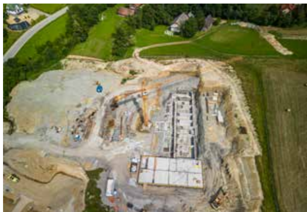
Budowa szkoły w Gródku - I etap
