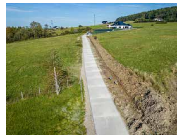
Droga betonowa Siolkowa
