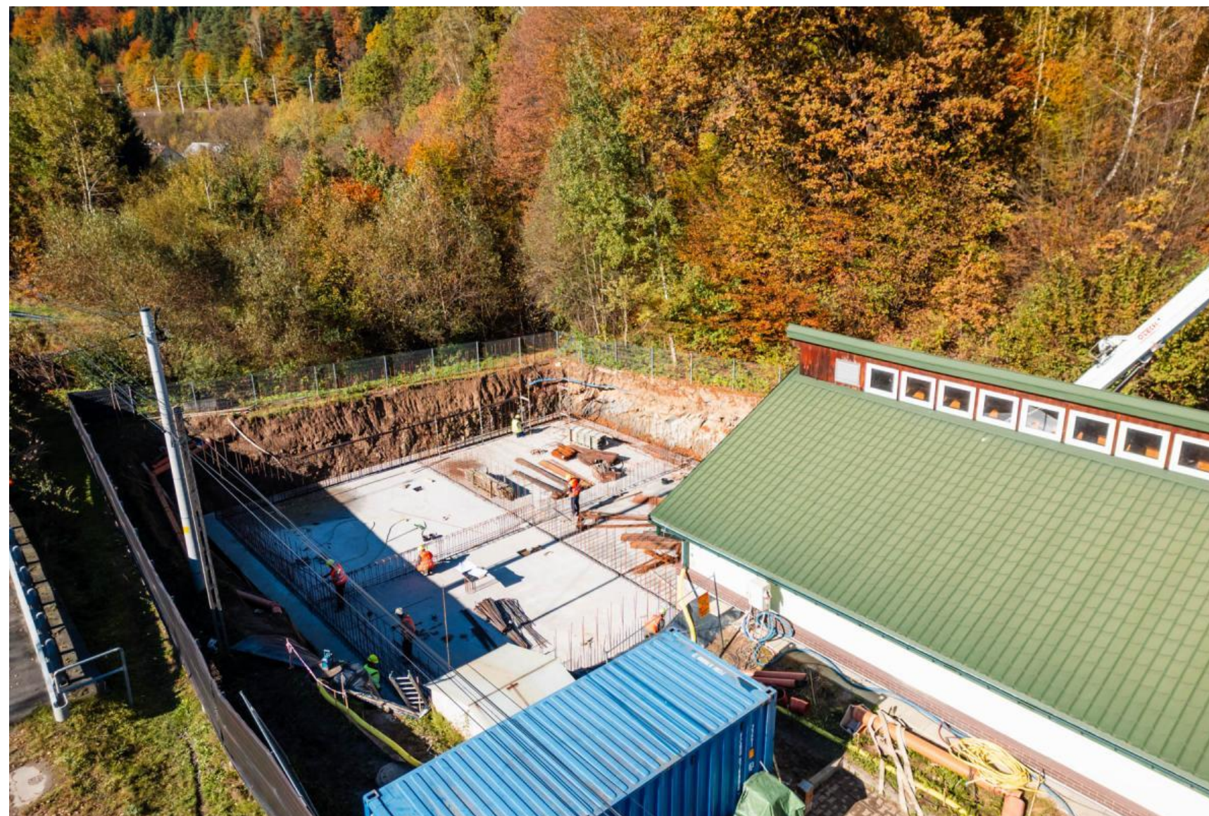
Postęp prac budowlanych (fot. Gmina Grybów)
