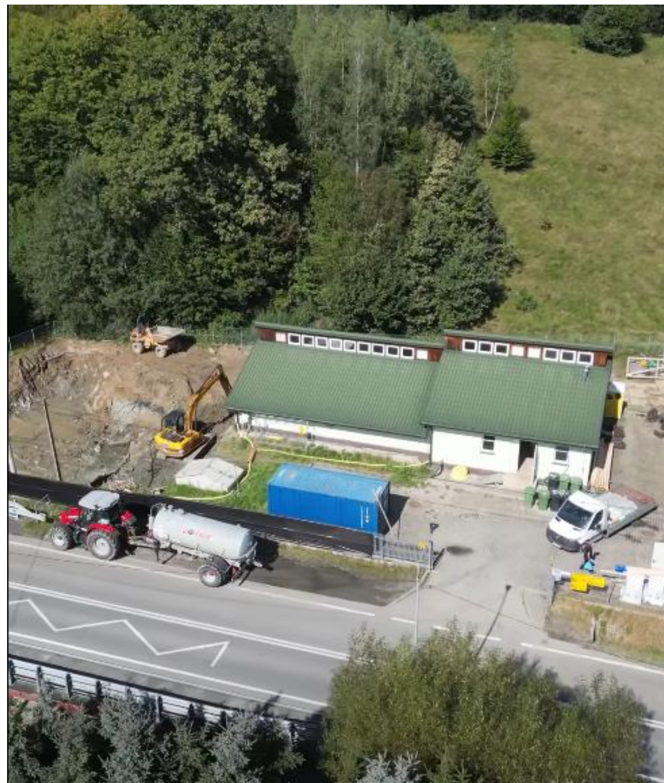
Postęp prac budowlanych (fot. Gmina Grybów)
